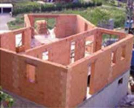
Les murs peuvent être réalisées en terre, pierre, brique ou parpaings. On peut également les réaliser en fabriquant une ossature en acier ou en béton armé fermée par une enveloppe.
