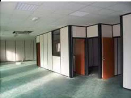
Elles peuvent être réalisées en briques creuses ou parpaings recouverts de plâtre, en béton cellulaire, en carreaux de plâtre, en plaques de plâtre à peindre fixées sur une structure métallique, en plaques de bois aggloméré fixées sur une structure
