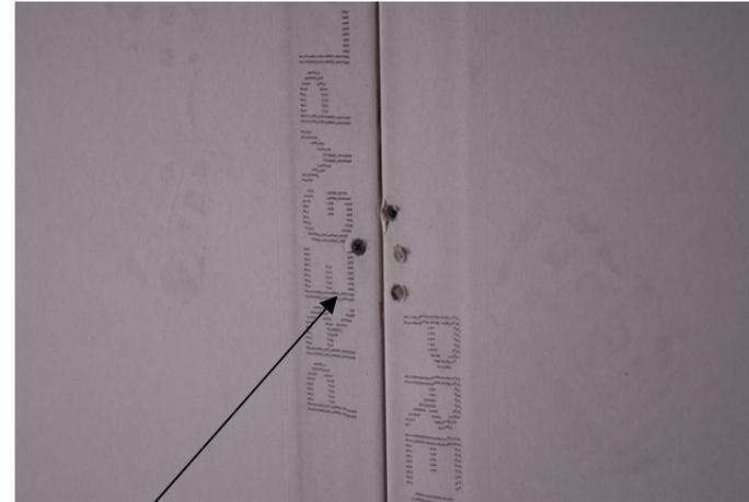
**Vis à la jonction de deux plaques de plâtre**
