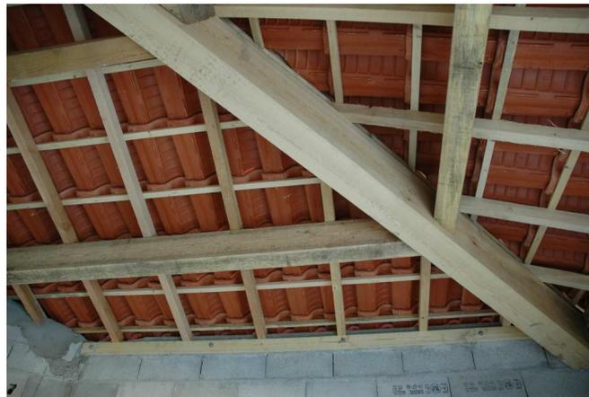
**Charpente traditionnelle réalisée sur le chantier avec de grosses poutres en bois appelés des pannes.**
