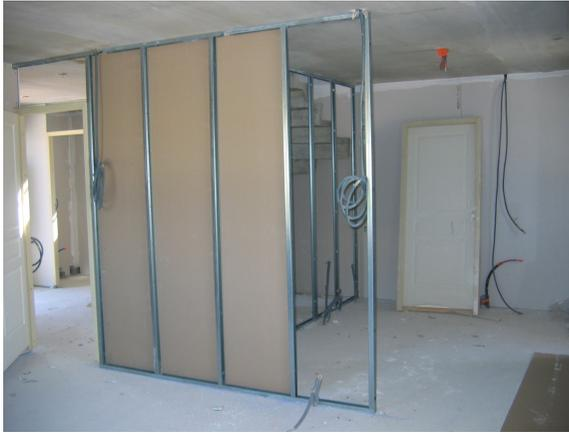
**Elles sont vissées sur l'ossature métallique de la cloison d'un côté... et de l'autre**
