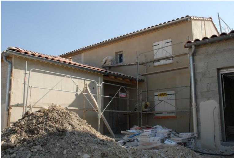
**On met en place des échafaudages afin de réaliser les enduits et peintures extérieures.**
