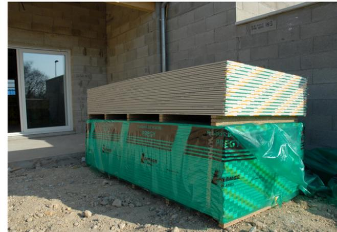
**Des plaques de plâtre ayant une épaisseur de 13 mm sont stockées et vont servir à la réalisation des cloisons.**
