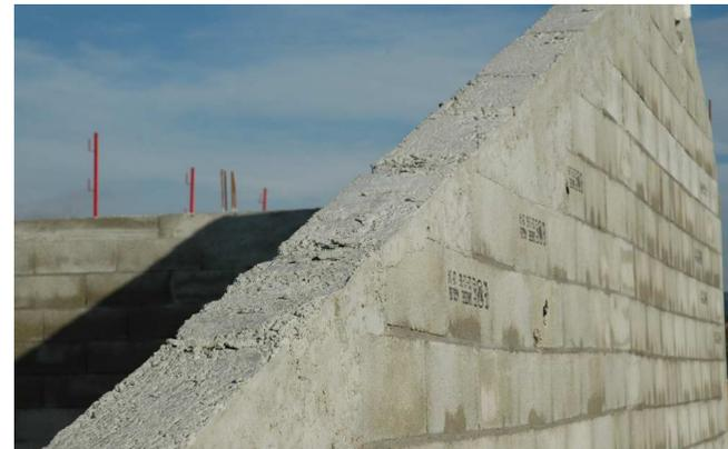
**Les murs des pignons sont obliques et reprennent la forme de la toiture**
