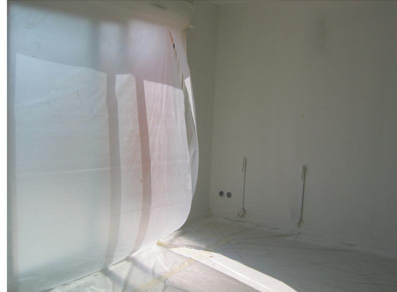
**On protège les sols et les fenêtres pour réaliser la peinture des cloisons.**
