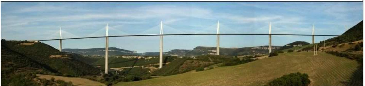
Un hauban est, généralement, un assemblage de câbles en acier destiné à soutenir le tablier d'un pont et à répartir les forces. Le hauban est fixé, d'un côté, à un pylône du pont et au tablier à son autre extrémité.
